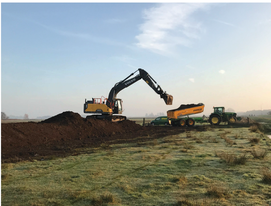
Proefkades Zuidelijk Westerkwartier
