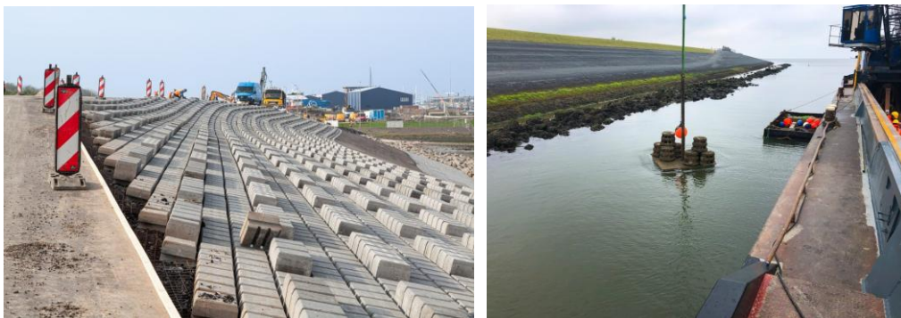
Afbeelding 5.9 en 5.10 Betonblokken met verhogingen in dijk bij de nieuwe tweede toegangsweg. De verhogingen breken de golven bij extreem hoogwater en storm (Lauwersmeerdijk.nl).
