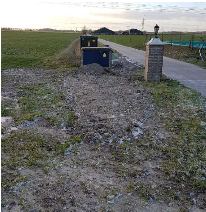
Dam 15: Extra puin aangebracht bij betonpad
