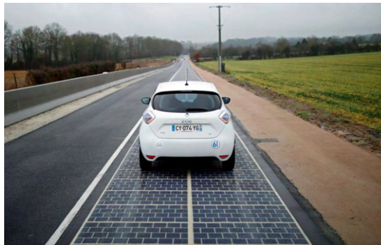
referentie zonnepanelen als proefstrook in de weg
