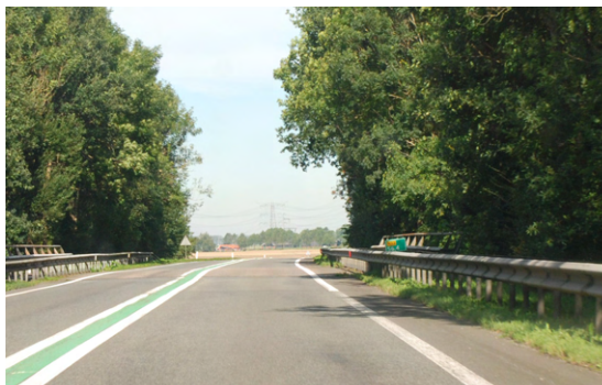
geleiderails aan buitenzijden op talud
