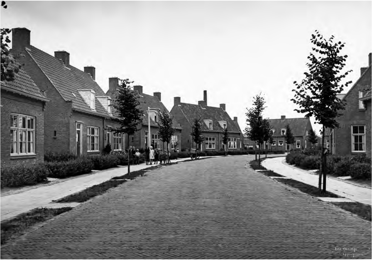
Normaalwoningen aan de Karel Doormanstraat in Appingedam, ontworpen door architect Klaas Olsmeyer
