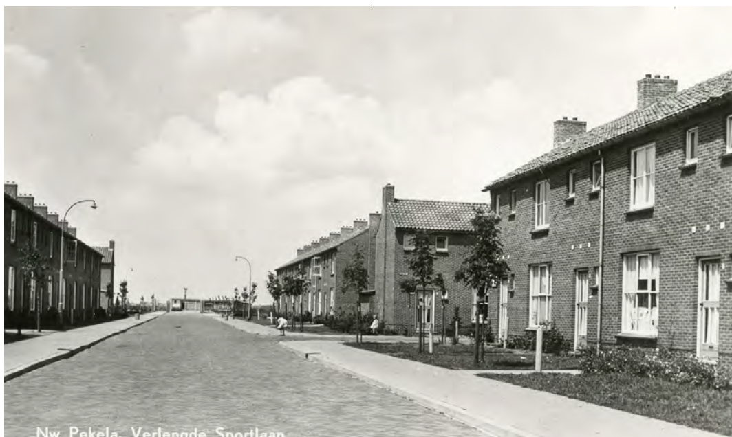
Woningen uit het 1000-woningenplan in Nieuwe Pekela
