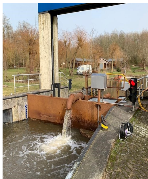
Figuur 5.2: Een van de twee stalen schotten van de tijdelijke vispassage bij keersluis HD Louwes. In het schot zijn rikketten aanwezig waar vissen doorheen kunnen zwemmen. De pomp zorgt voor een lokstroom.
