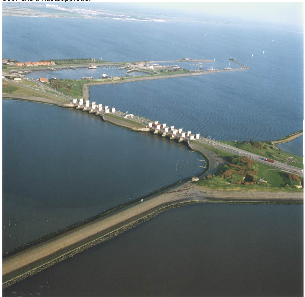
Foto 4.6. Afsluitdijk met Lorentzsluizen. (Foto Rijkswaterstaat)
