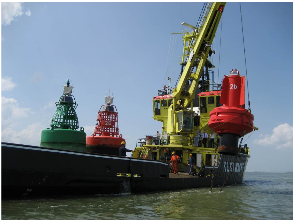
Foto 4.3. Leggen boeien voor vaarwegmarkering. (Foto Rijkswaterstaat)
