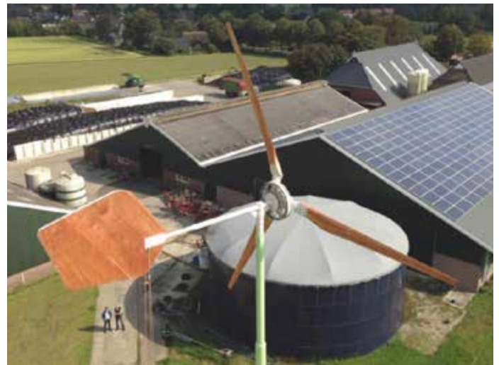
2.9 De regio als nieuwe kraamkamer van bedrijven die voorlopen in de energietransitie, zoals EAZ-wind in Hoogezand
