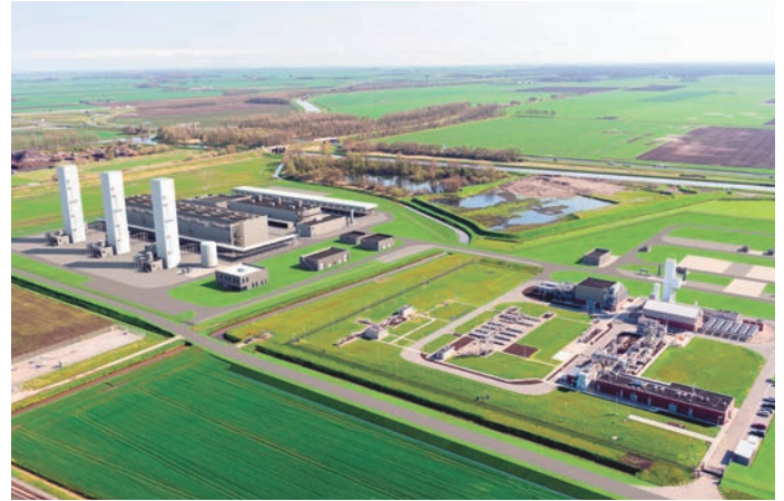
4.21 In de Tussenklappenpolder wordt gewerkt aan de stikstofinstallatie (hier op 3D-beeld), deze zorgt samen met het windpark N33 voor een schaalvergroting in het landschap
