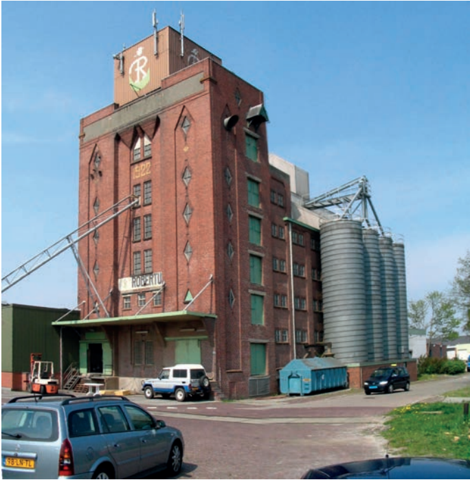
3.10 Herstructurering en herbesteding van (delen van) oude bedrijventerreinen biedt mogelijkheden voor bedrijven en voor de aanliggende stedelijke gebieden
