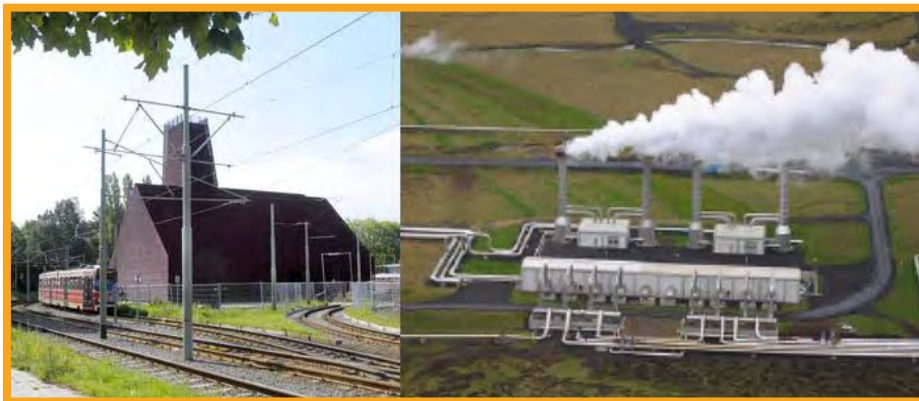
Figuur 3.6. Links een locatie waar aardwarmte wordt gewonnen voor verwarming van huizen (Den Haag). Rechts een geothermiecentrale waar elektriciteit wordt opgewekt (IJssland).
