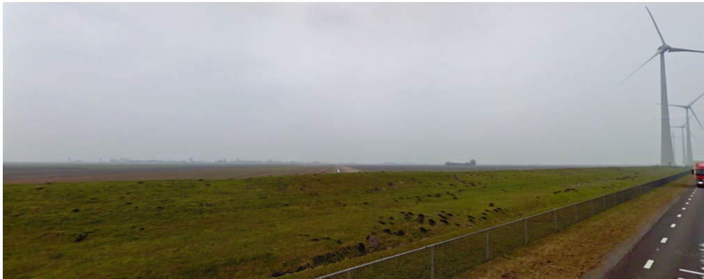
Figuur 3.3 Projectgebied vanaf de Eemshaven gezien (Google Streetview)
