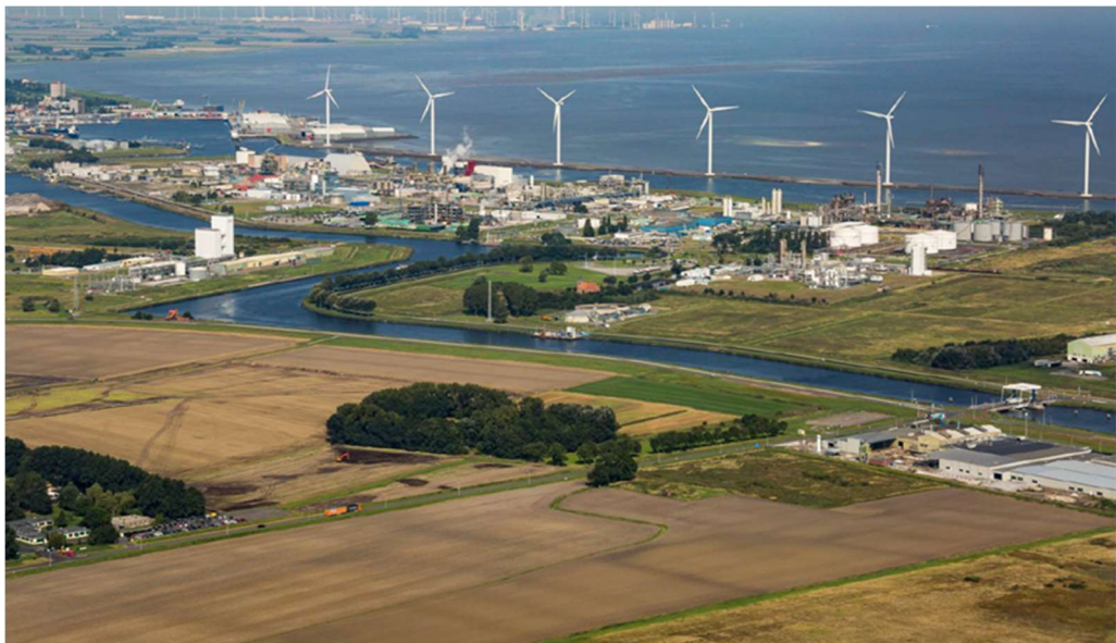
Figuur 2.1 Foto huidige situatie industrieterrein Oosterhorn
